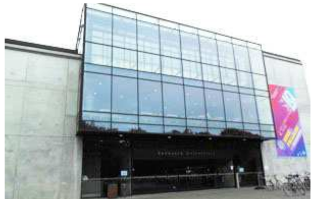
南デンマーク大学 (注1) のメインエントランス
